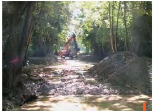
Les travaux de restauration ont concerné le remodelage du lit mineur de la rivière qui s'était enfoncé de plus d'un mètre en raison des déséquilibres hydromorphologiques provoqués par la présence du barrage.
